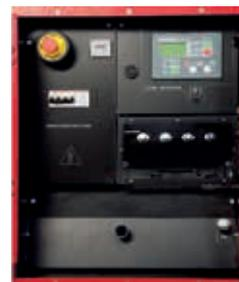
AS: Automatische Schalttafel, Kühlmittel-Vorwärmssystem, Kranverladeöse
